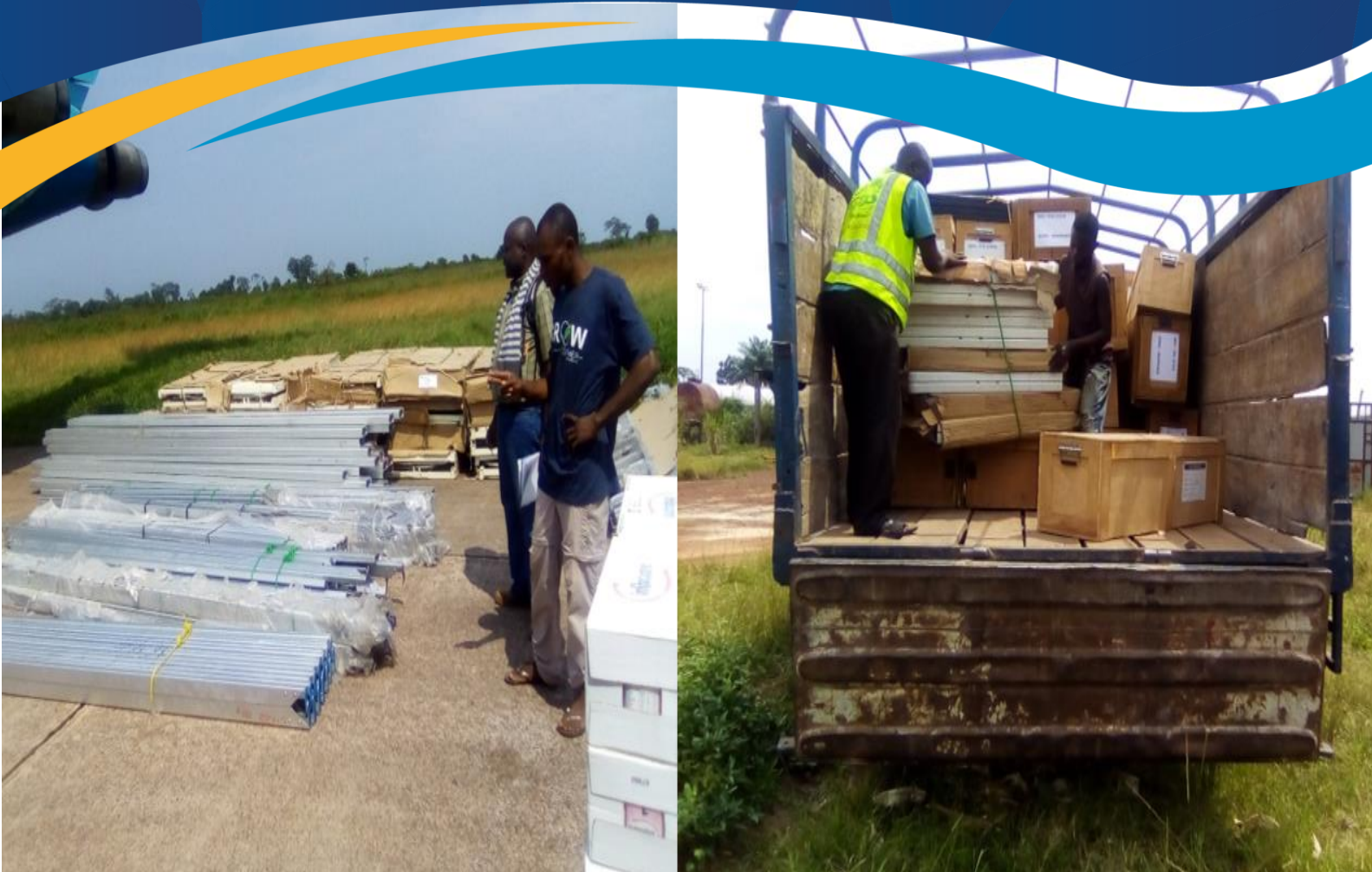
Réception des équipements de la construction des bases vie
